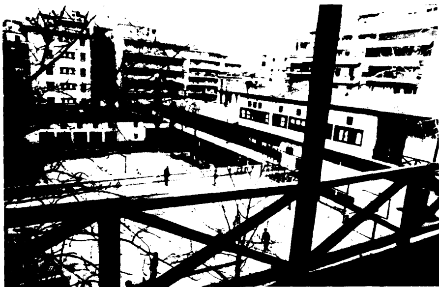
Πειραματικό σχολείο Θεσσαλονίκης (1933-35) – Γενική άποψη
