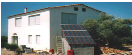
Αυτόνομο φωτοβολταϊκό σύστημα σε κατοικία μόνιμης διαμονής στο Ρέθυμνο Κρήτης.
