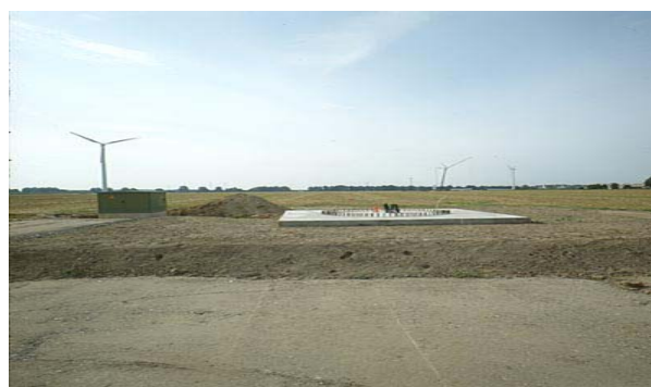
Κατασκευή βάσεων στήριξης
