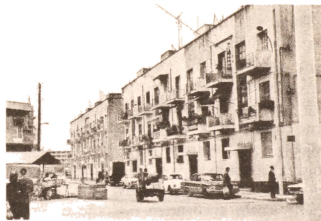
Οι δύο τελευταίες πολυκατοικίες του συγκροτήματος στο Δουργούτι.
