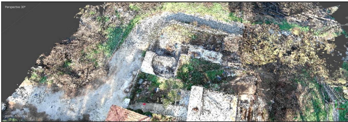
Εικόνα 19 : Εικόνα του περιβάλλοντα χώρου από την δεξιά πλευρά της εισόδου του ακινήτου.
