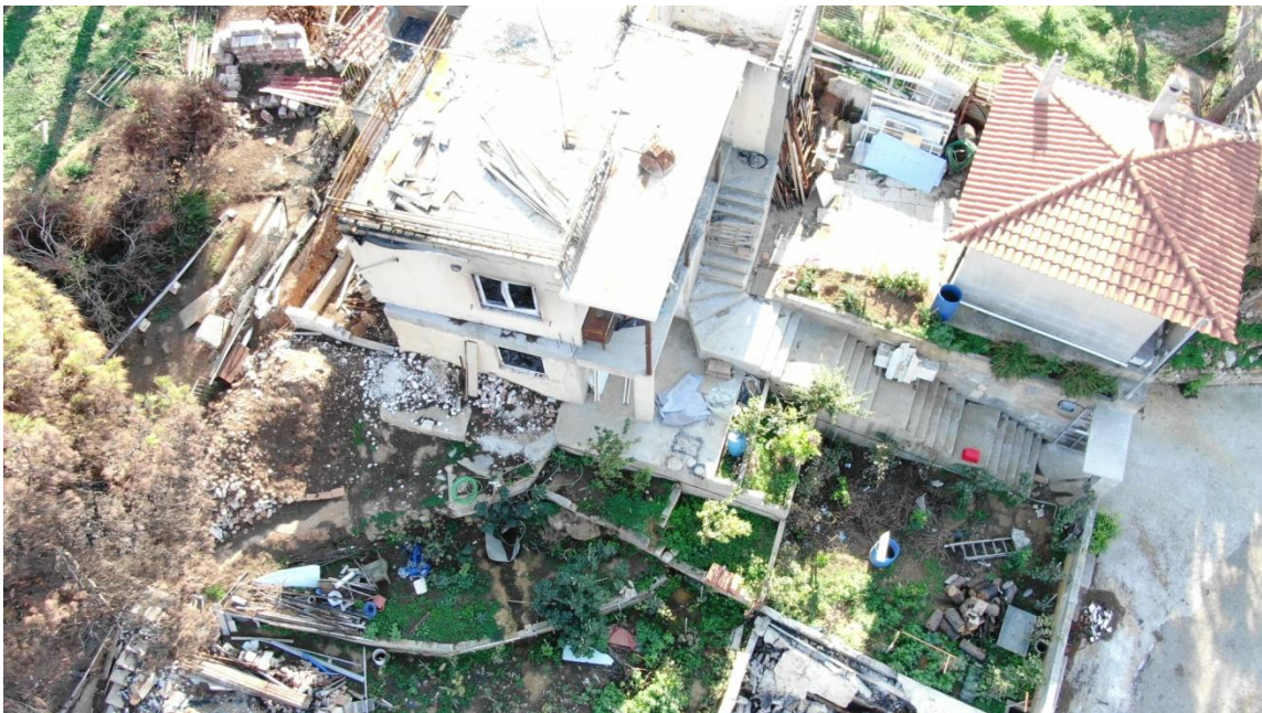
Εικόνα 3: Σε αυτή την εικόνα δίνεται έμφαση στο μέγεθος της καταστροφής του ανοιχτού χώρου του οικοπέδου καθώς προστατευτικοί τοίχοι, σίδερα αλλά και άλλα δομικά στοιχεία έχουν λιώσει και καταστραφεί από το μέγεθος της φωτιάς που έπληξε το ακίνητο.
