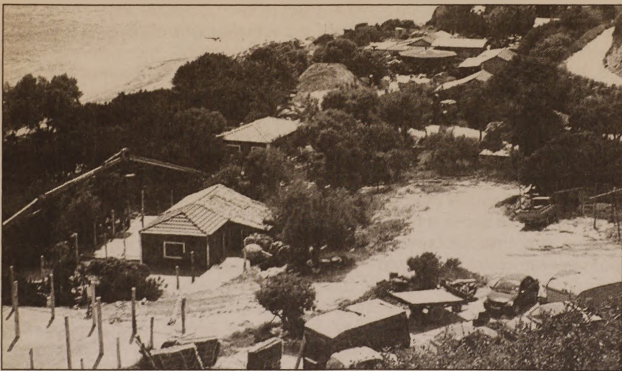
Τα παράνομα κτίσματα που αντί να κατεδαφιστούν επεκτείνονται.
