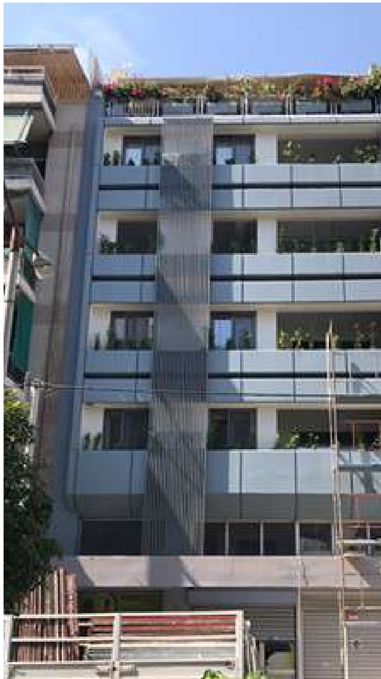
Εικόνα 2: Φωτο Ακινήτου κατά τη διάρκεια της Ανακαίνισης
