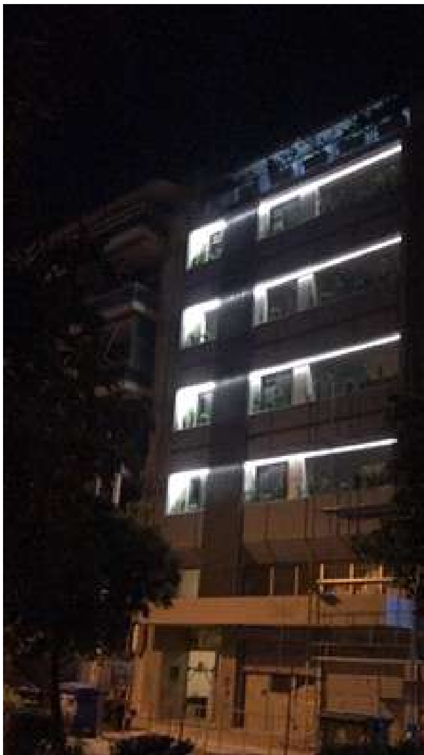
Εικόνα 3 : Φωτο Ακινήτου κατά τη διάρκεια της Ανακαίνισης
