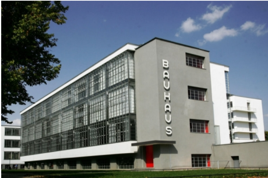
Εικόνα 32: Gropius, κτίριο Dessau, 1925-26
