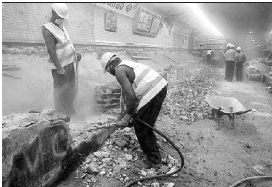
Dos obreros inmigrantes trabajan con un martillo neumático en las obras de la estación de metro de Callao. / RICARDO GUTIÉRREZ El País, 06/02/2005
